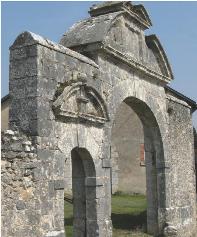
Fig. 13. Landes-Le-Gaulois : portail de l'ancien château de la Motte 1673.
