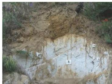
**Fig. 10. Bloc éboulé, rue Vendômoise en 2011. Ancrages dans le tuffeau.**
