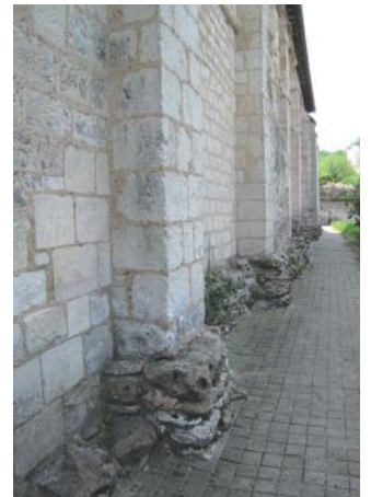
Tuffeaux et silex : église Saint-Genest. Les bases en silex, roche dure et résistante à l'action de l'eau, provenant de la couche d'argile issue de l'altération du tuffeau après le retrait de la mer vers la fin du Crétacé, forment les soubassements des murs et des contreforts en tuffeau. Un amusant « jeu géologique » consiste à identifier dans la façade les roches initiales et les fossiles.
