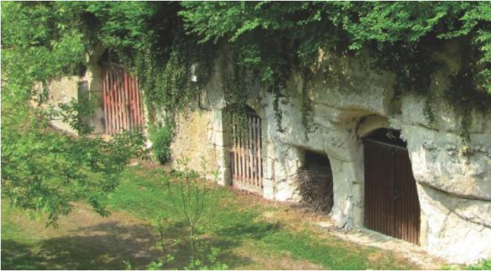
Fig. 10. Impasse Saint-Vincent. Les versants de la ravine initiale ont disparu remplacés par des parois délimitant le fossé sud du château. Le tuffeau extrait fut employé pour la construction du château et sans doute des maisons du village. Les caves ont été creusées dans un second temps.
