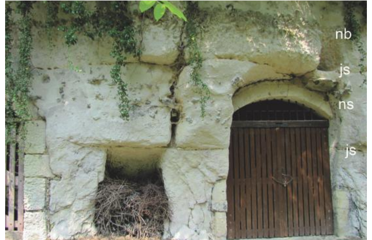
Fig. 11. Tuffeau blanc. js : joint de stratification. ns : strate à silex (terriers silicifiés). nb : niveau bioturbé. Se reporter à la fig. 6 pour les caractéristiques de la roche. Les caves et les parois de l'impasse sont privées ; respecter les affleurements.
