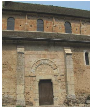
Tuffeaux et silex : église Saint-Genest. Les bases en silex, roche dure et résistante à l'action de l'eau, provenant de la couche d'argile issue de l'altération du tuffeau après le retrait de la mer vers la fin du Crétacé, forment les soubassements des murs et des contreforts en tuffeau. Un amusant « jeu géologique » consiste à identifier dans la façade les roches initiales et les fossiles.
