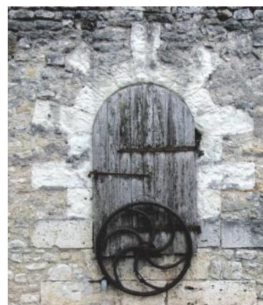
Puits mural : soubassement en calcaire de Beauce, arcade en pierre de Bourré.
