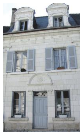
Soubassement en pierre de Pontlevoy, élévation en pierre de Bourré.
